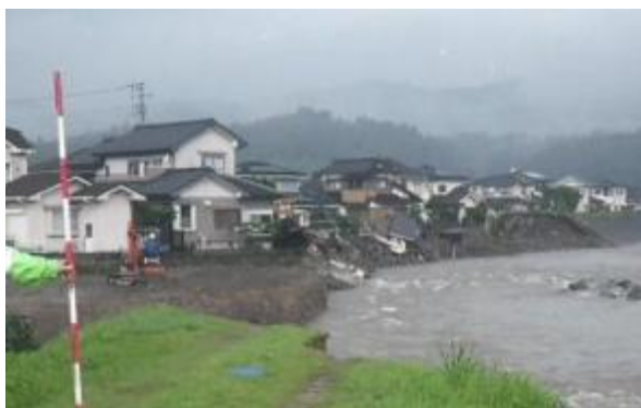
河岸侵食による家屋の倒壊(花月川)
