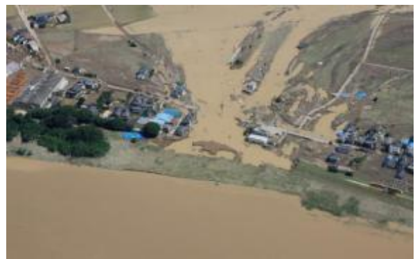
堤防決壊による家屋の流失(鬼怒川)
