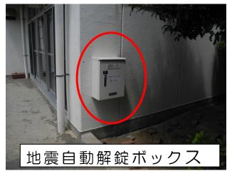
(2) 地震自動解錠ボックスは、震度6弱以上の揺れで自動的に解錠する仕組みになっています。
