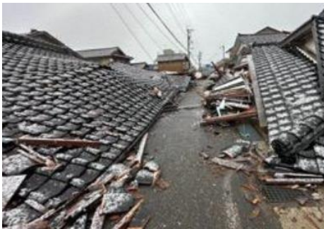
能登半島地震における建物被害状況
