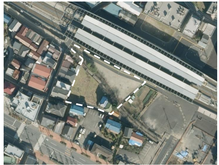
(写真③) 駅南口の整備箇所
