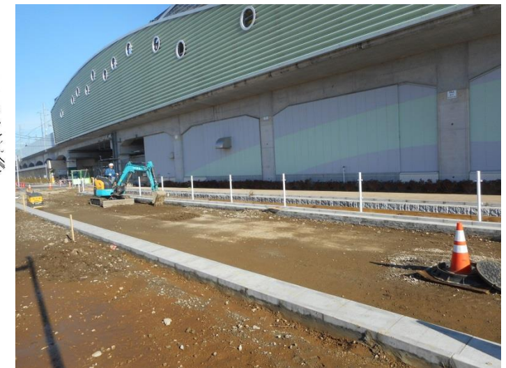
(写真④) 駅南口の整備状況
