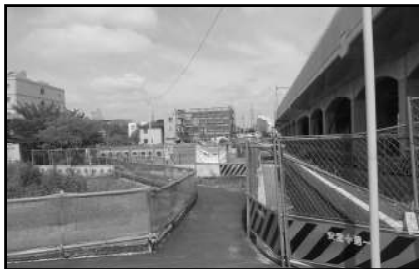
一部整備をおこなった新堀水路(写真C)
