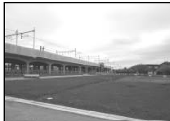
駅南側整備工事の完成
