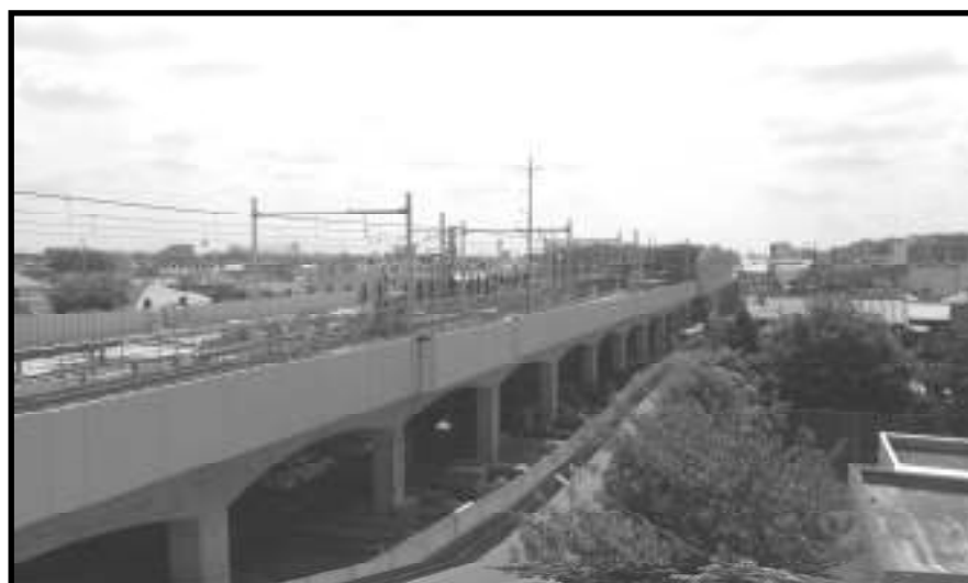
高架工事の状況
