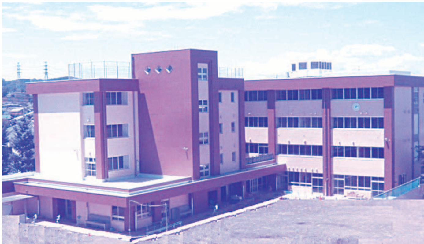
稲城第一小学校 新築校舎
