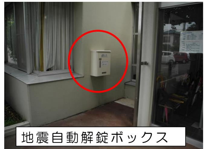
(2) 地震自動解錠ボックスは、震度6弱以上の揺れで自動的に解錠する仕組みになっています。
